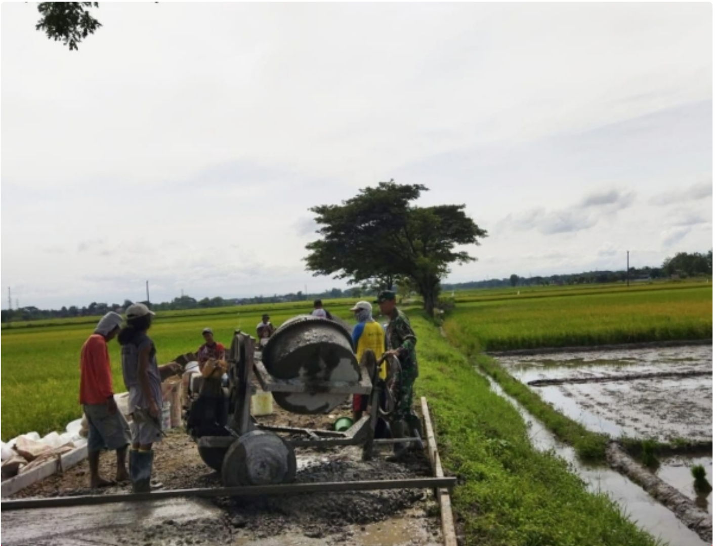
Gotong Royongnya Babinsa Juwiring Bantu Betonisasi Jalan
